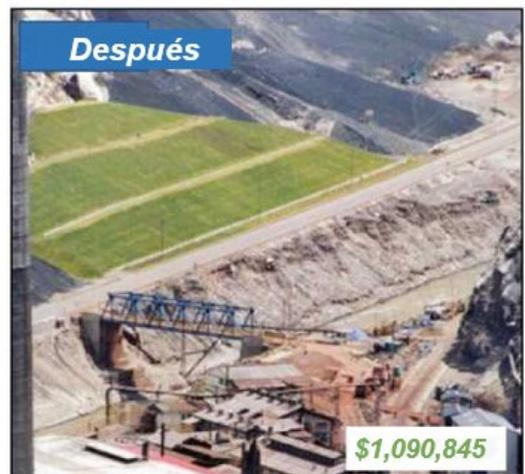
*Parte sur de la planta con depósito de escoria estabilizada al fondo (c. 2008).*
